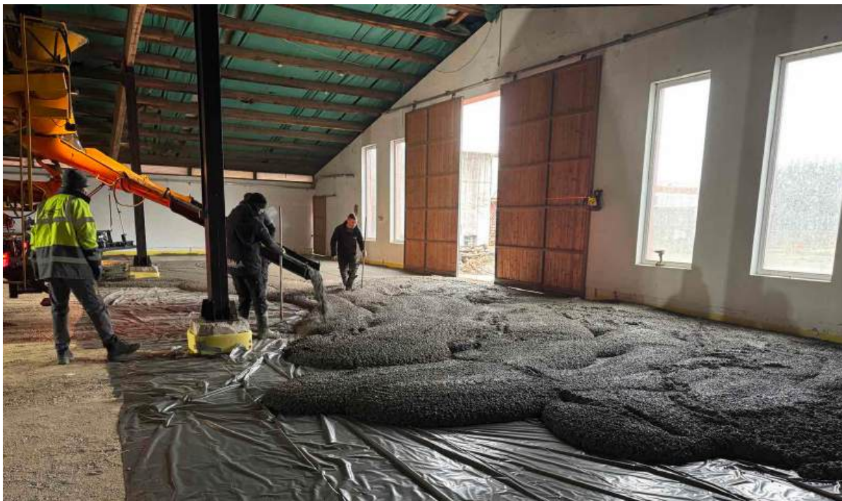
Betoniranje tal v novih depojih (foto: Robert Zapušek, 9. 12. 2024).
