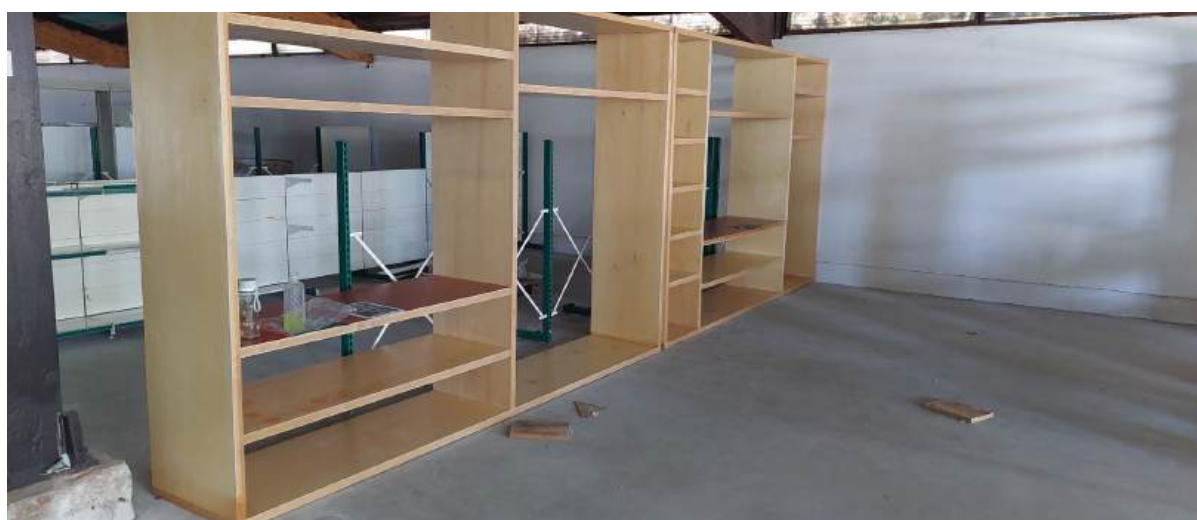
Postavljanje polic za ogledni depo (foto: Robert Zapušek, 1. 8. 2025).
