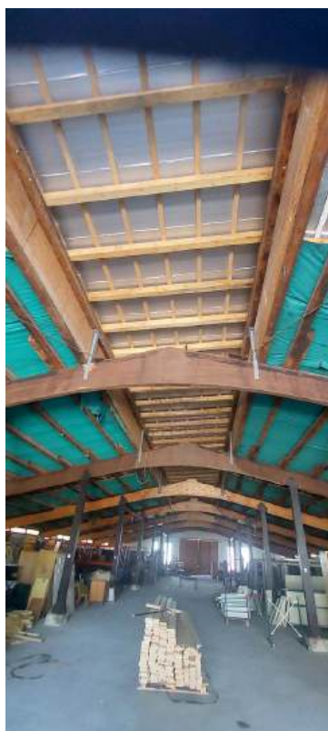
Položena nova kovinska streha z izolacijo (foto: Robert Zapušek, 22. 9. 2025).
